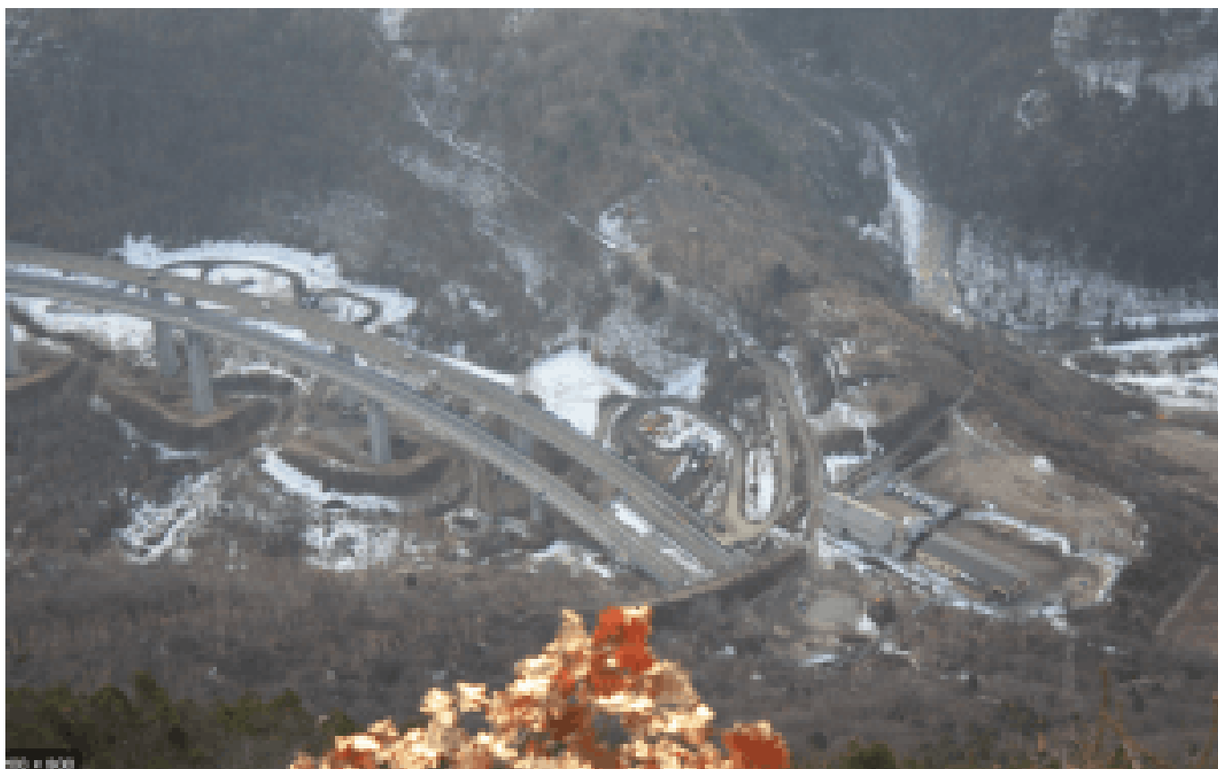
Il cantiere in Val Clarea “deforestata”
