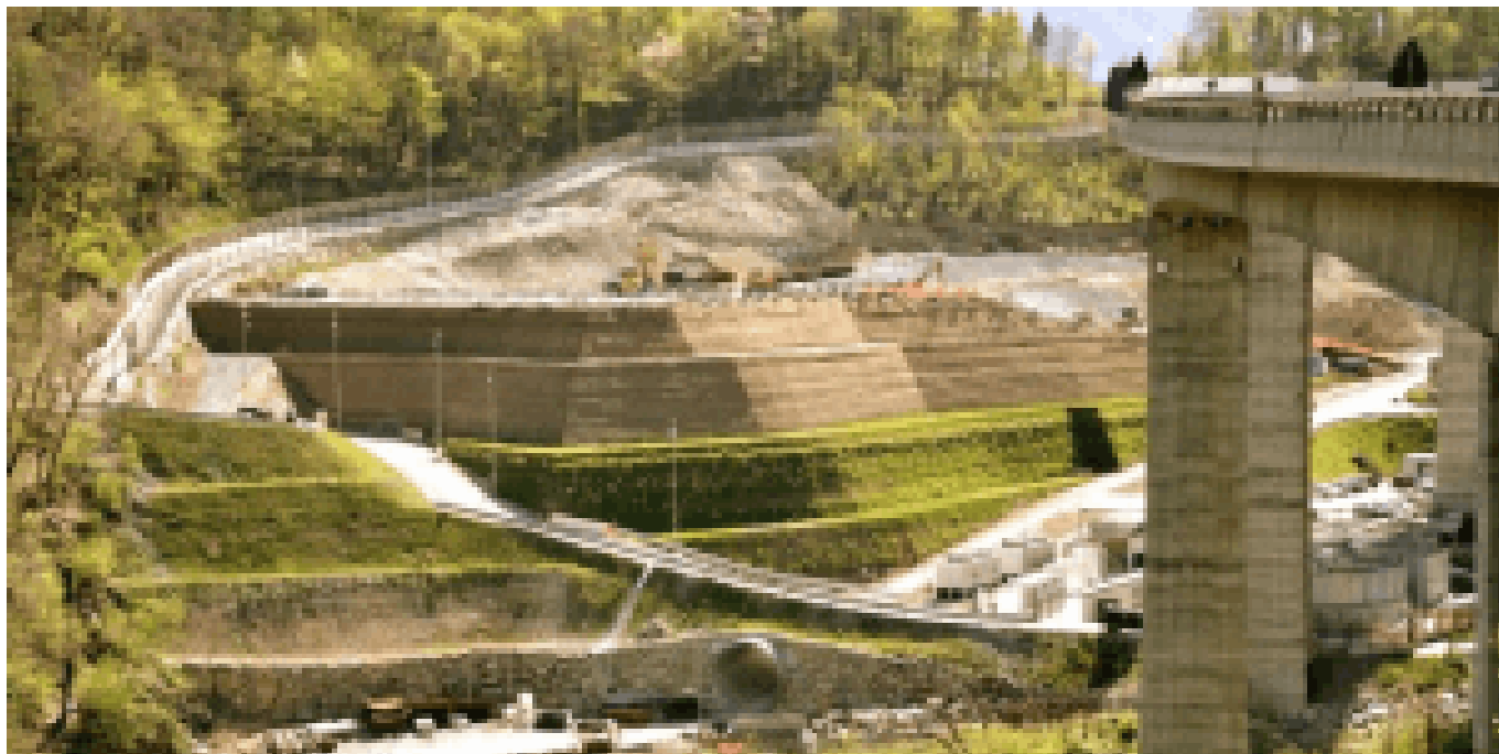
Cantiere TAV in Val Clarea 2
